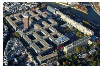
El campus está compuesto por una *rejilla* de edificios de 6 plantas con soportales peatonales. En las intersecciones se encuentran las escaleras y ascensores para acceder a los hasta 4 edificios que conectan.
